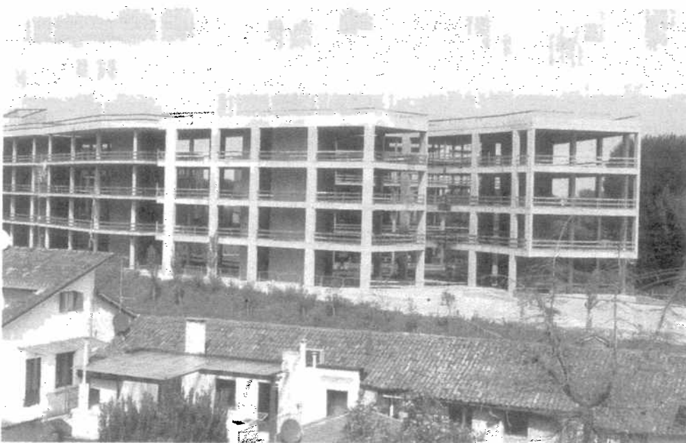
Il complesso di Borgo Berga a due passi dalla Rotonda e da villa ai Nani: «Una vostra battaglia perduta».
